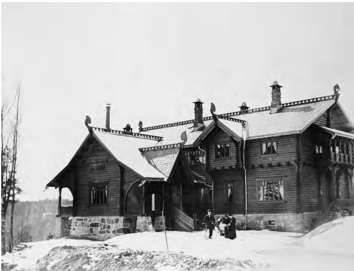
Slik så huset som på Sarabråten som ble revet i 1917 ut i 1898. I dag står bare grunnmuren igjen. Foto: Ukjent person/Oslo bymuseum (Creative commons 3.0 lisens).
